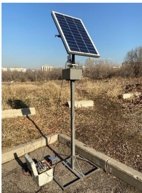
Рис. 3 - Экспериментальная установка фотоэлектрической системы
